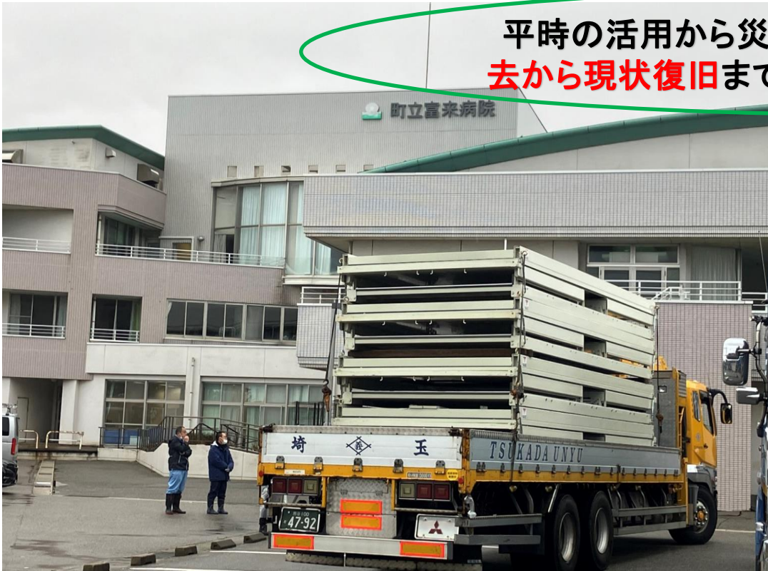
フラットパック4基をトラックにより輸送
