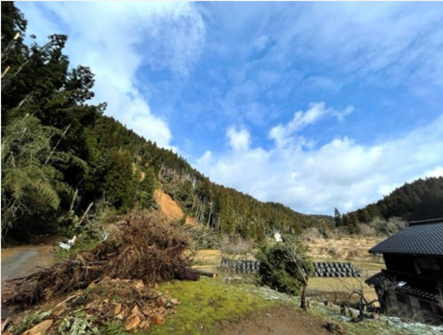
道路寸断の状況
