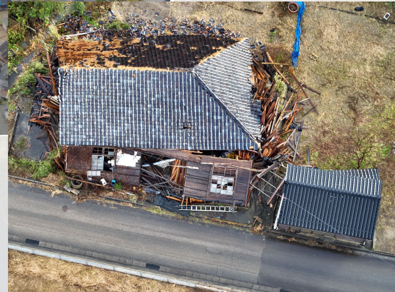
仮設住宅設置予定地域の 被災状況の確認
