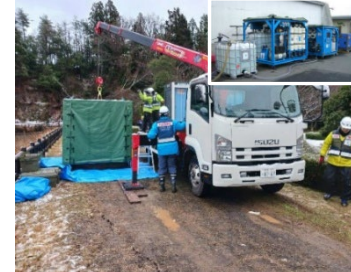
可搬式浄水装置の設置 (石川県珠洲市)
