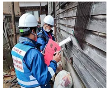
被災建築物応急危険度判定 (石川県穴水市)
