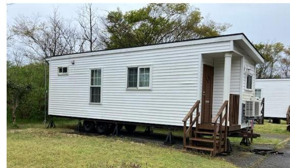
ジャッキ調整・交換、上下水繋ぎ直し作業(1日)で復旧「10台」
