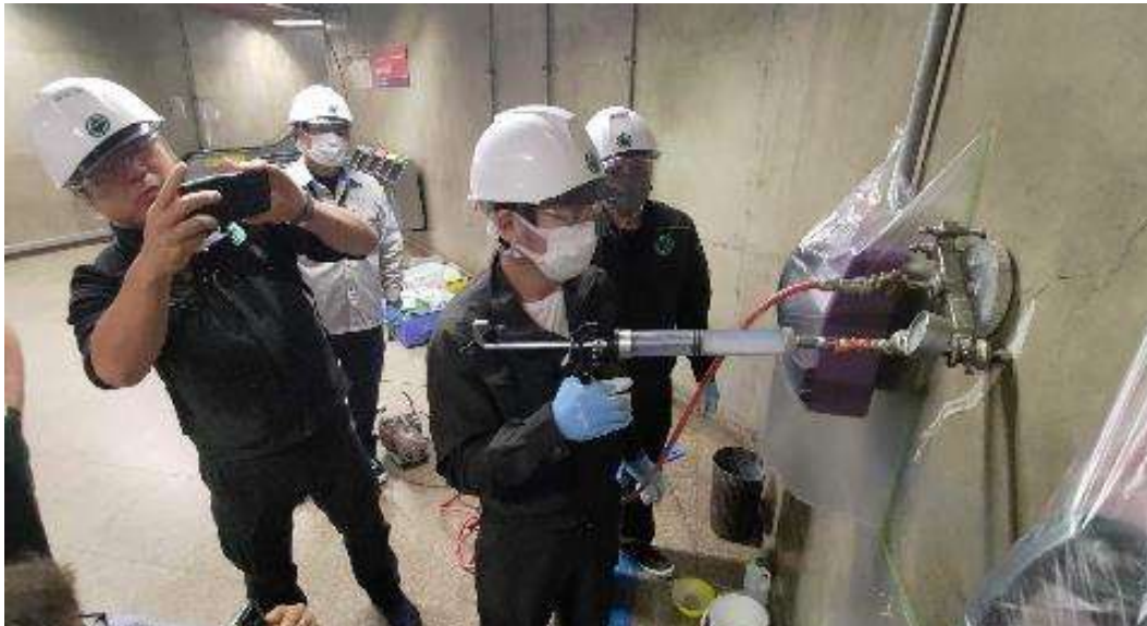
JICA事業を活用してブラジル国ルース駅での施工風景
